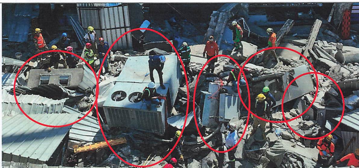
Figura 5: Equipo de aire acondicionado ubicados en el techo
