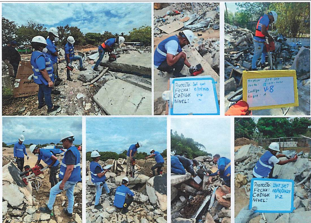
Figura 11: Realización de ensayos destructivos y no destructivos en el centro de acopio
