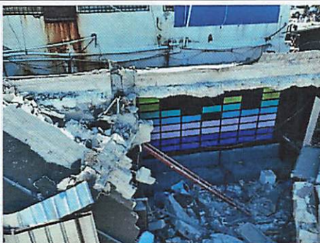
Figura 8: Perfil metálico de refuerzo bajo viga encima del escenario, nótese la placa de acero referida
