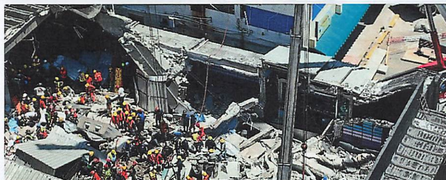
Figura 9: viga perimetral y columnas colapsadas
